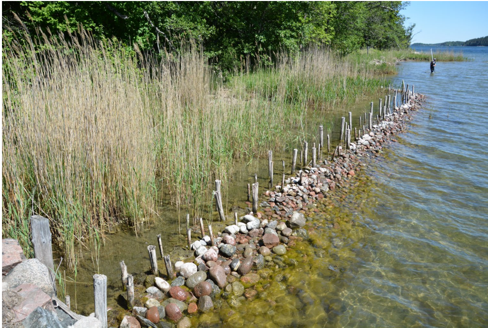
Figur 7. Exempel på en stenrevell i Stockholms skärgård, som anlagts för att främja tillväxt av vass i en fartygsled. Stolparna ingår inte i stenrevelln, utan är en rest från en tidigare åtgärd. (Foto: Anette Björlin, SGI)
