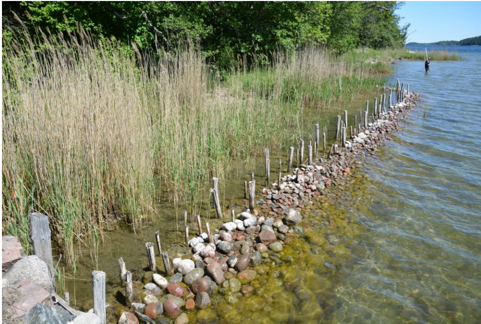
Figur 8. Exempel på en stenrevel i Stockholms skärgård, som anlagts för att främja tillväxt av vass i en fartygsled. Stolparna ingår inte i stenreveln, utan är en rest från en tidigare åtgärd. (Foto: Anette Björlin, SGI)
